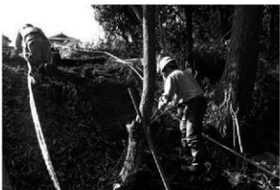
6 10トレンチ 調査風景 (南から)
