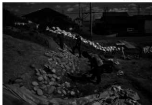
1 20トレンチ 調査風景(北から)
