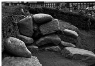
5 1トレンチ 奥壁石積み(北西から)
