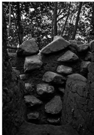
6 1トレンチ 石室北側壁立面(北西から)
