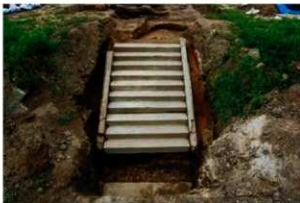
3 階段全景 (南から)
