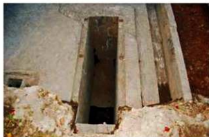
第60図 電波標定機受信所 出入口 (東から)
