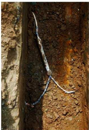
4 工事立会で出土した電線
