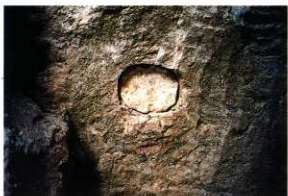
94 6号横穴墓 玄室、西側壁の副室(蓋あり) (南東から)
