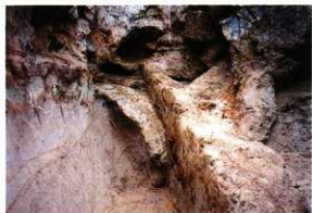
66 5号横穴墓 羨道部内岩盤崩落状況(南東から)
