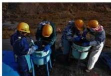
写真18 土壌洗浄作業
