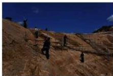
写真9 足場組立作業
