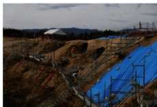
写真11 調査区北半部 作業状況
