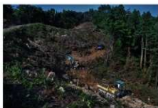
写真7 伐採木搬出作業
