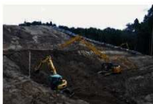
写真8 表土掘削作業
