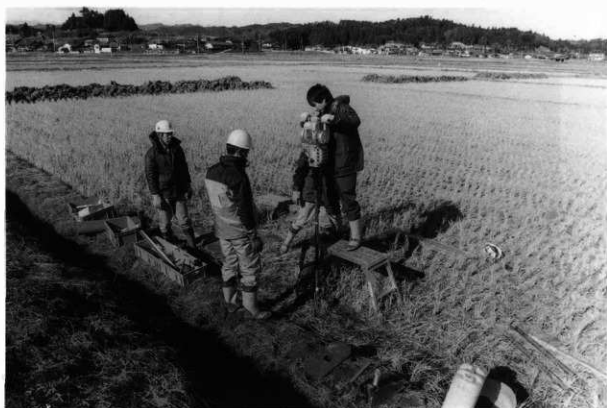
ボーリング調査
