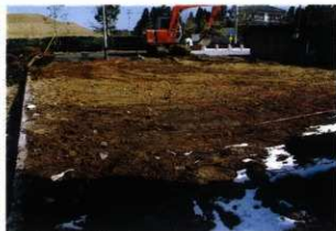
1 調査着手前（南から）
