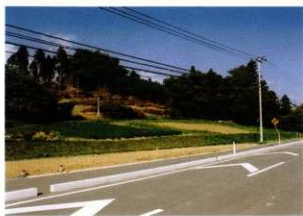
1 調査着手前(南西から)
