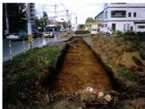
2 試掘トレンチ完掘状況 (南から)
