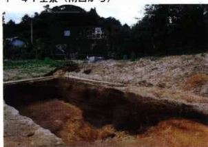
3 SD6断ち割り状況(南から)
