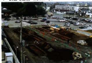
2 A地区全景 (南東から)
