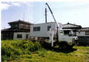
7 現場小屋設置状況 (1)
