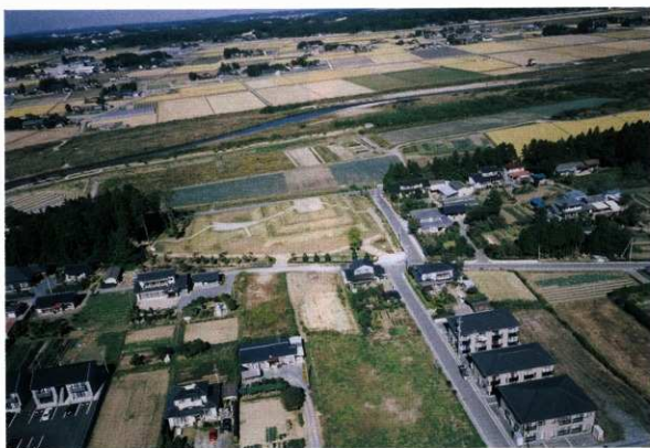
2 第2次調査地近景（南から）
