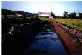
51 4号トレンチ（南から）
