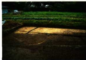
8 1号掘込地業（北から）
