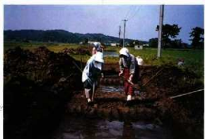
58 19号トレンチ (南から)
