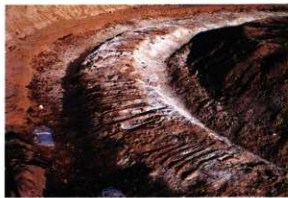
172 鉄筋検出状況
