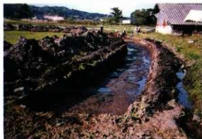
50 3号トレンチ（南から）
