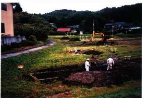
70 7～11号トレンチ (南東から)
