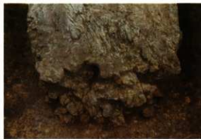
70. 東側粘土塊 崩壊した小口面（西から）
