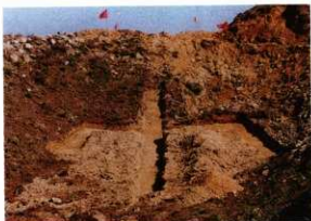
18 15T (北西から)
