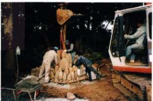
写真52 墓石塔建設作業 墓石を積み上げる
