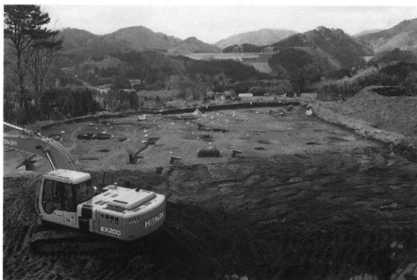
90 調査風景 南半部分
