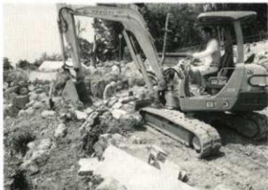
第37図 重機による近現代石垣の除去
