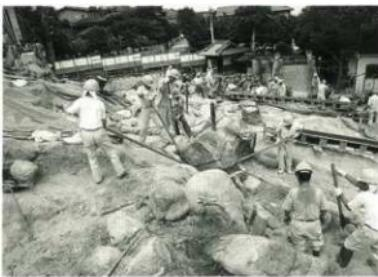
第35図 花崗岩礫の除去・移動作業
