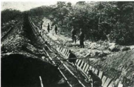
第23図 六麓荘開発時の水道・ガス・電気埋設工事
