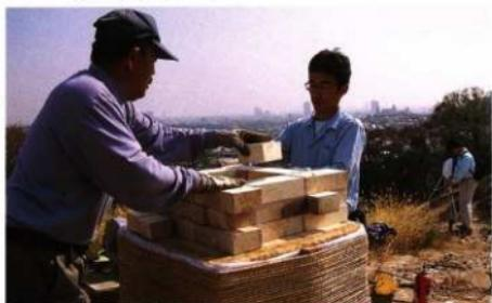
溶解炉をレンガや壁土で構築する
