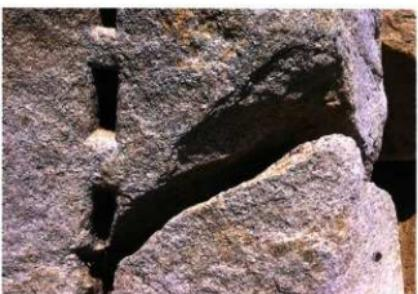
A地区第81号石材 矢穴・亀裂箇所(拡大)
