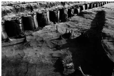
SD11・13合流部杭群 (北から)
