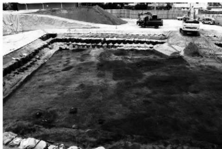
2区南部第6b層上面遺構 検出状況（東から）
