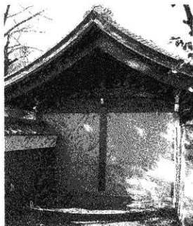
写真1 1区調査前状況(東から)
