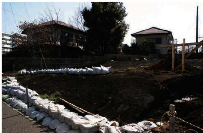
1. 第8次調査No.2調査区近景(南西から)
