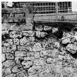
東立面の北側、橋床及び側壁の現況（東より）
