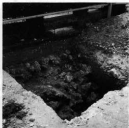
同上、部分的に中込め石が見られる（南より）
