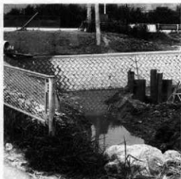
カフンジャー川河川改修工事
