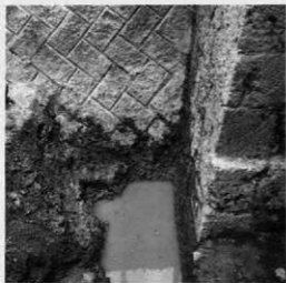
東立面の南側部分の橋台下部の試掘（北より）
