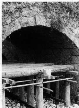
アーチ保護の支保工の構築
