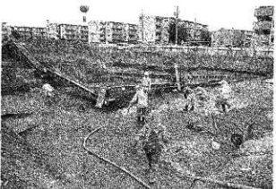
写真2-9 ク (14次6) 区排水作業 (南西から)
