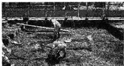
Ⅱ区掘削風景
