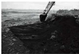
写真8 調査区北東端表土除去 (5/27北西から)
