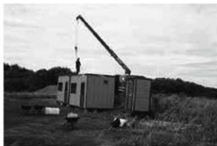
写真25 プレハブ撤去 (8/31北東から)
