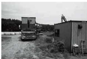
写真10 プレハブ搬入作業 (6/1南西から)
