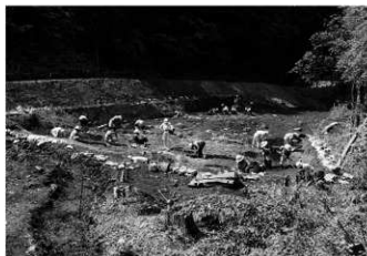
3 A区作業風景(東より)
