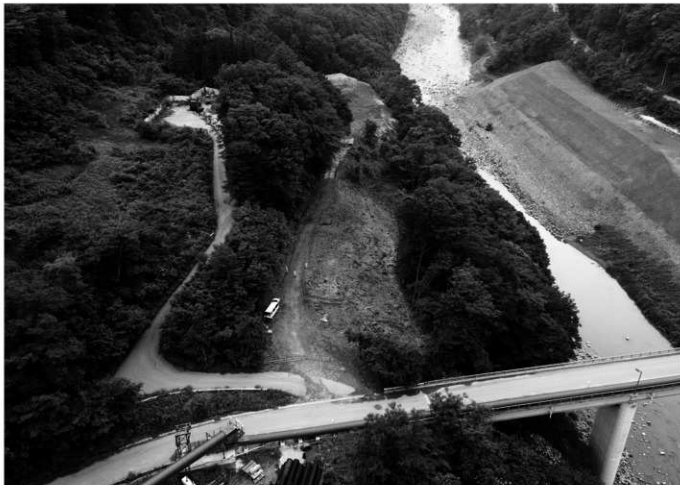
1 A区調査前全景(北東より)
