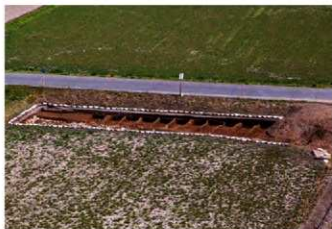
3 4号復旧坑全景（南西から）
