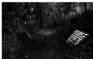
埋め戻し完了
