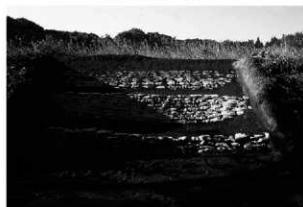
虎口(南側) 埋め戻し完了
