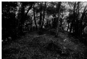
2-2T埋め戻し完了
