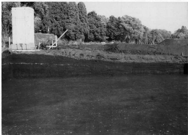
東壁土層断面状況
