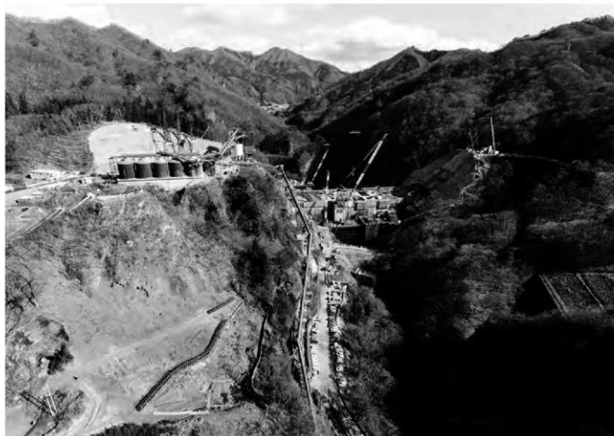
1. 調査区全景(西より)
