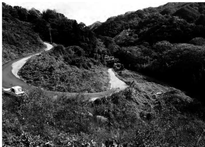
2 調査前風景（南西から）
