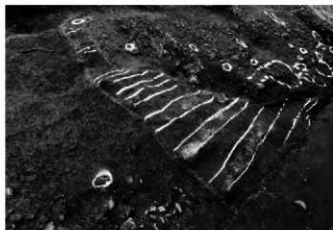
1. A区As-A下土砂崩れ全景(西より)
