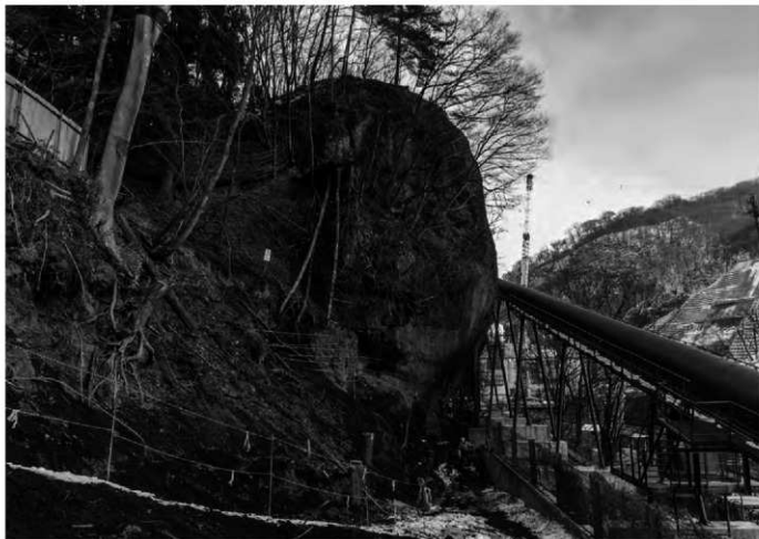
1 B区北岩張り出し状況(西より)
