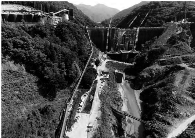
1 調査区遠景(西より)
