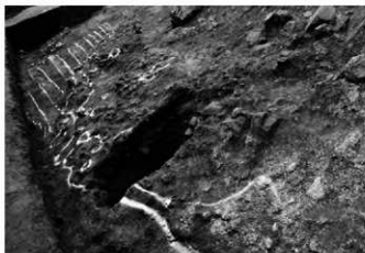
2. A区As-A下土砂崩れ全景(西より)
