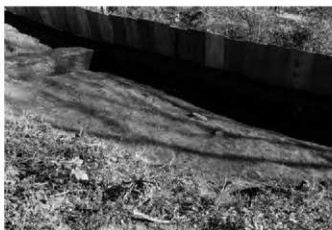
7. A区東部軽石状況(西より)
