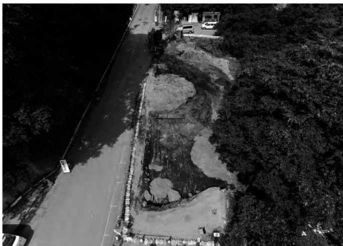
2 A区南調査区航空写真
