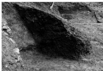
8 1区1面 西側崩落土、畑 (南から)
