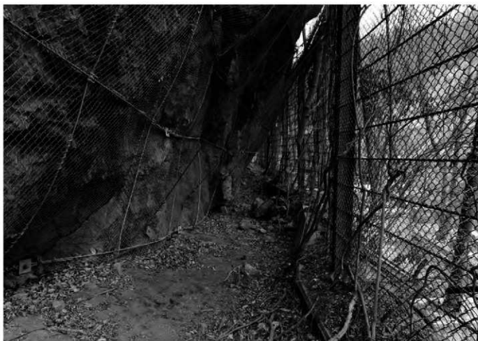
2 B区北調査前状況(西より)
