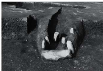
1 2区92号竪穴建物 カマド1 焚口部天井石崩落状況 南西から
