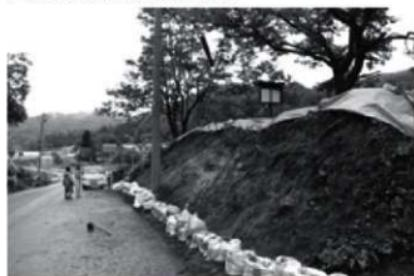
県道への崩落土を防ぐための土嚢配置
