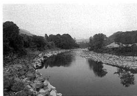
つんだし車跡（敷島橋より）
