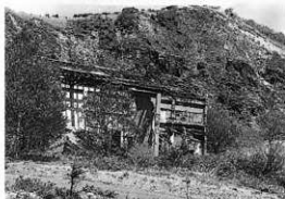
小串鉾山跡 変電所跡
