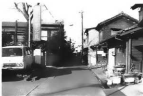
尾島地内鎌倉街道（河口農科医院付近）
