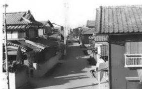
角瀬地内の東ルート
