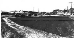
八幡町と板鼻境 西馬場からの板鼻道
