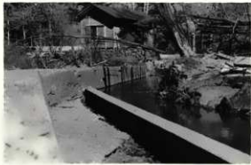
旧蛇木発電所 取入れ口跡(マスの養殖に改修利用)
