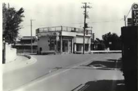
藤岡市大戸町 諏訪神社地先の旧道と県道分岐点
