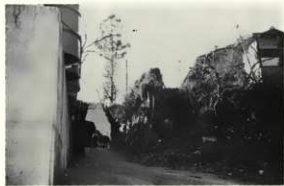
勝山 川から峠にかかる付近 (旧道の一部と当時の石垣)
