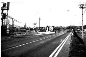
板鼻バイパス(国道18号線)(右国道、左中山道への入口)
