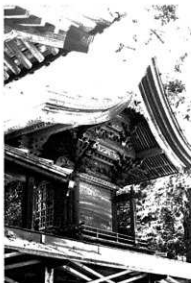
旧大杉社々殿(現棟東村新井)
