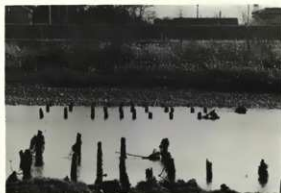
鳥川木橋の橋枕 左岸（北側）より
