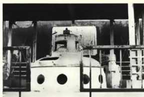
日本織物株式会社発電所跡のタービンと発電機
