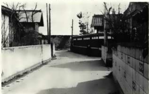
川合渡 堤防越付付近
