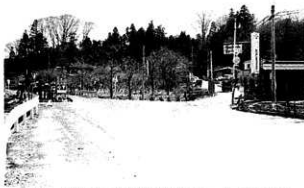
水上町 川上北の利根川右岸と左岸ルートの合流付近
