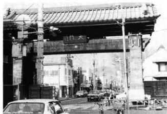
⑰ 解体前的大门（太田市）
