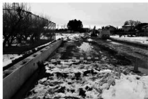
着手前状況(南東から)
