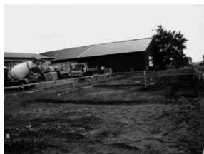
工事立会全景 (東から)
