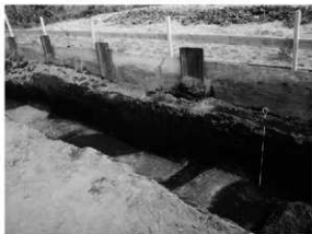
工事立会 A 区遺構検出状況 (南東から)
