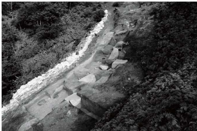
1. C地区の調査状況（南西から）
