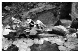
第15図 崩落石材の撤去（第2東門）
