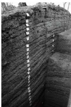
3. 土層の版築土層
