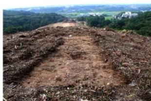
2TR 完掘状況（南東から）
