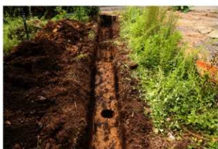
城井遺跡 (個人住宅下水道 2)
