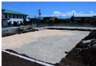
保護盛土敷設状況 (集合住宅 南西から)
