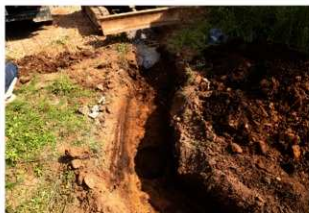
城井遺跡 (個人住宅下水道 1)
