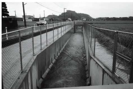
3. 完成した水路（北西から）
