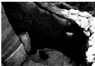
版築土塁と列石（A2トレンチ）
