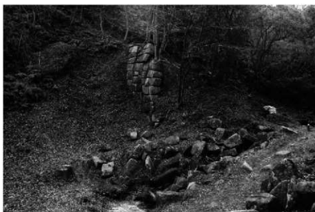
2. 東側石塁遠景 （北西から）
