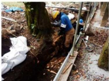
工事⑥ 樹根の切断と掘削
