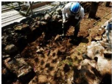
工事① 挖方整形 栗石などの掘削
