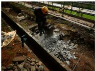
工事① 挖方整形 既存コンクリート基礎破碎
