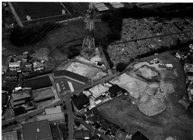
2. 調査区航空写真 (南から)
