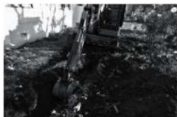
H. 中央第二宿舍給水設備改修工事 (西より) 調査番号: 2018
