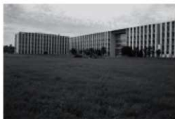
B. 調査状況 (TP 21 遠景：北西より)
