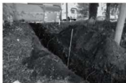
G. 中央第二宿舍給水設備改修工事 (北より) 調査番号: 2018
