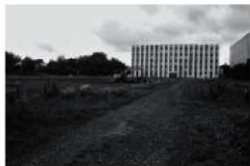
D. 調査状況 (TP14 遠景：北より)
