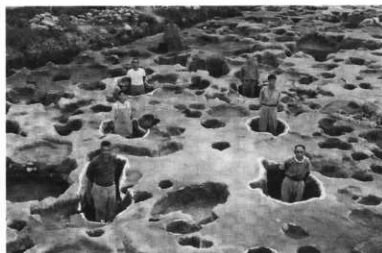
第1建物跡（北から）
