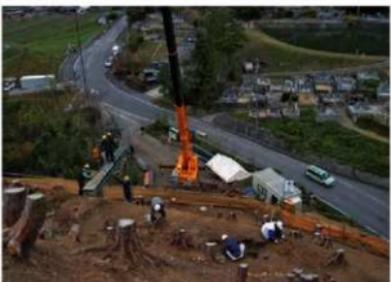
⑥ ラフタークレーンによるベルトコンベアの撤去状況
