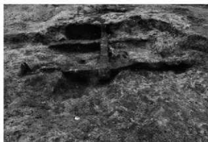
第3号竖穴建物跡 カマド断面 (D-D') (SE→)
