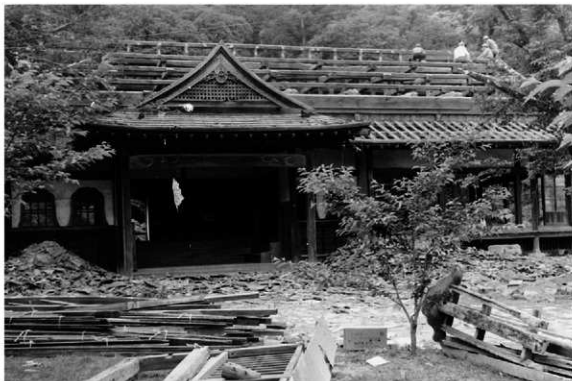
写真17 昭和45年 三の丸御殿の解体状況 小野英治氏画像提供
