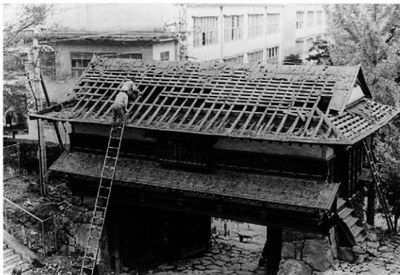
写真20 昭和50年 三の丸櫓門の屋根修理状況
