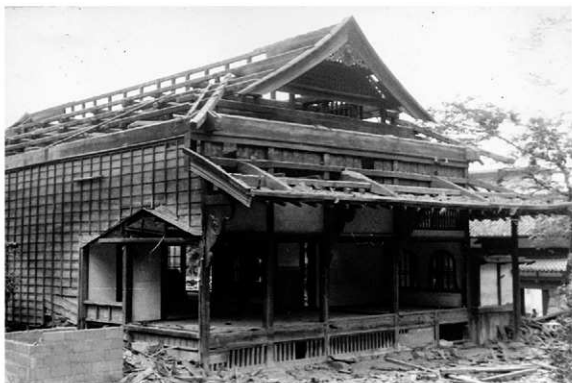
写真18 昭和45年 三の丸御殿の解体状況 小野英治氏画像提供
