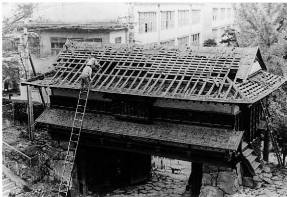
写真20 昭和50年 三の丸櫓門の屋根修理状況
