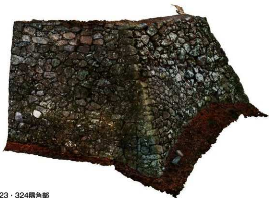
石垣No.323・324隅角部
