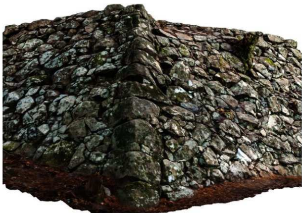
石垣No.324・325隅角部下部
