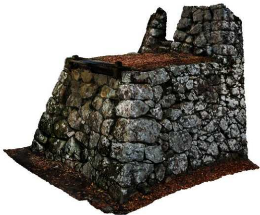
石垣No.110・111隅角部
