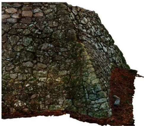
石垣No.323・324ハバキ石垣
