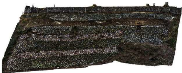
写真3 石垣No.225～238全景
